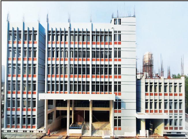
নবনির্মিত একাডেমিক ভবন ও ল্যাবরেটরি ভবন
