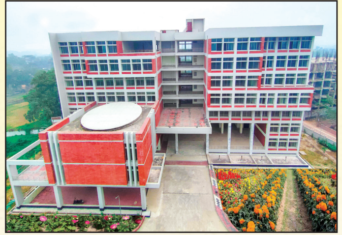
নবনির্মিত আইসিটি ইনকিউবেটর ভবন
